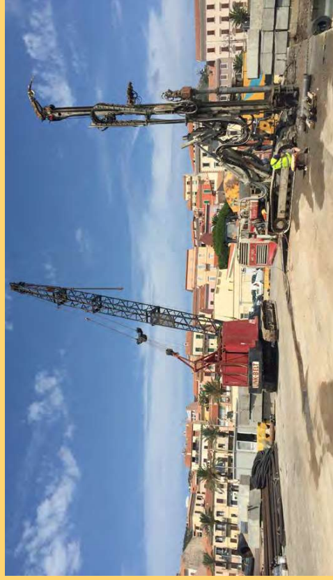
ISOLA LA MADDALENA - BANCHINA POSTE COMMITTENTE : COMUNE DI LA MADDALENA CONSOLIDAMENTO E RIPRISTINO BANCHINA CON MICROPALI E POSA MASSI CICLOPICI
