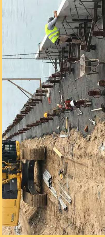
PORTO DI PORTO TORRES COMMITTENTE : SERLU COSTRUZIONI SRL REALIZZAZIONE DI MICROPALI Ø250 LUNGHEZZA 15,00 METRI
