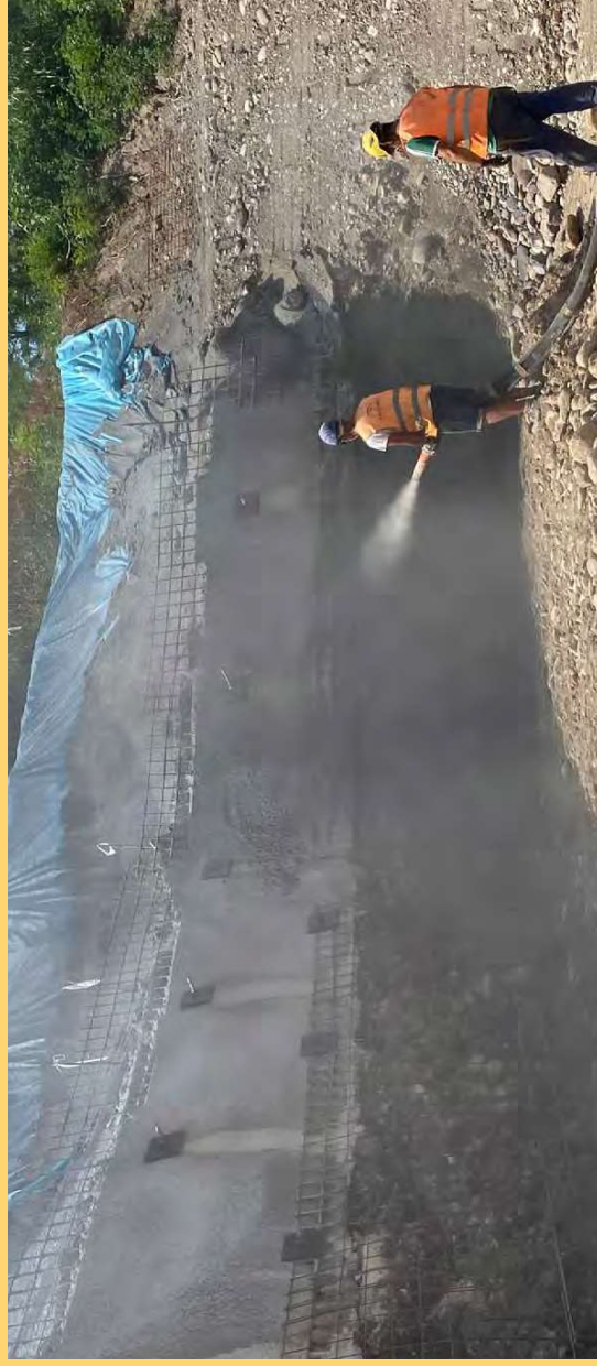
2 - Rinforzo con rete elettrosaldata e cemento proiettato
