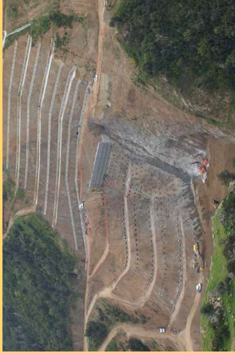
ORGOSOLO - DIGA DI COMBIDANOVU COMMITTENTE: GRUPPO ITINERA Spa PROGETTO: OPERE DI CONSOLIDAMENTO E SCHERMO DI TENUTA
